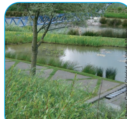
Bassin de filtration
